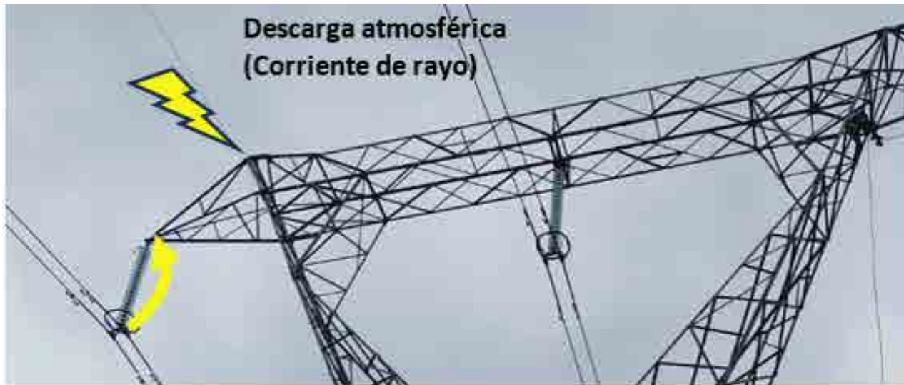
Figura 3. Torres a 765 kV
